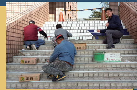
106 年三位一體施工情形
